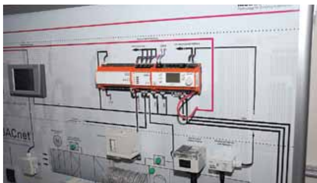
Лаборатория автоматического управления инженерными системами
