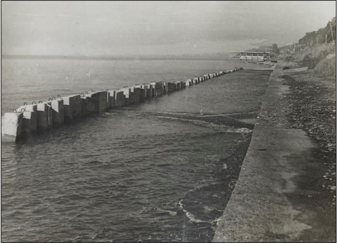
Рисунок 1.15 – Вид береговой линии сразу после установки блоков в 1981 г.
