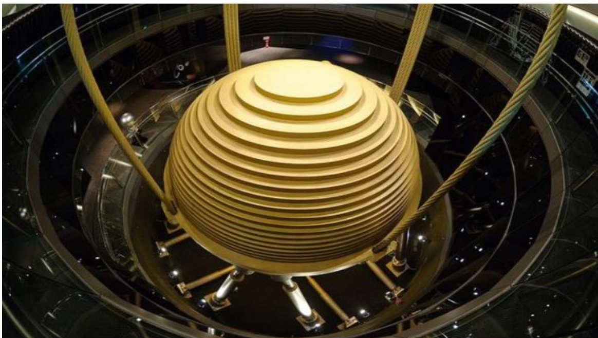
Рисунок 1.8 Инерционный демпфер на высотном здании Тайбэй
