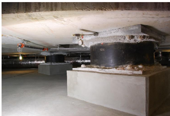
Рисунок 1.6 Сейсмическая изоляция основания
