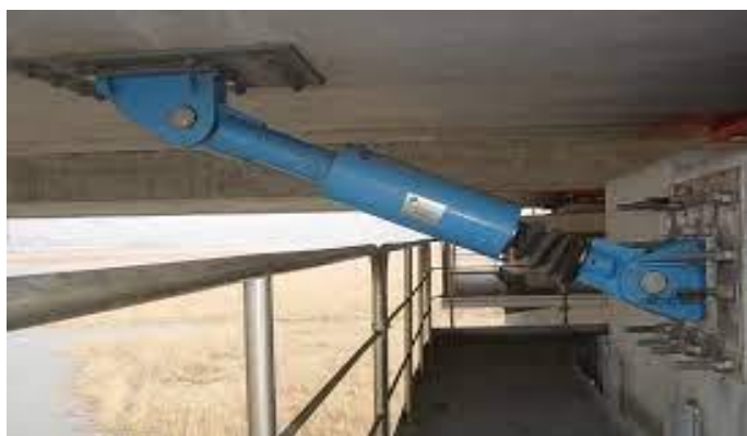
Рисунок.1.7 Сейсмический демпфер
