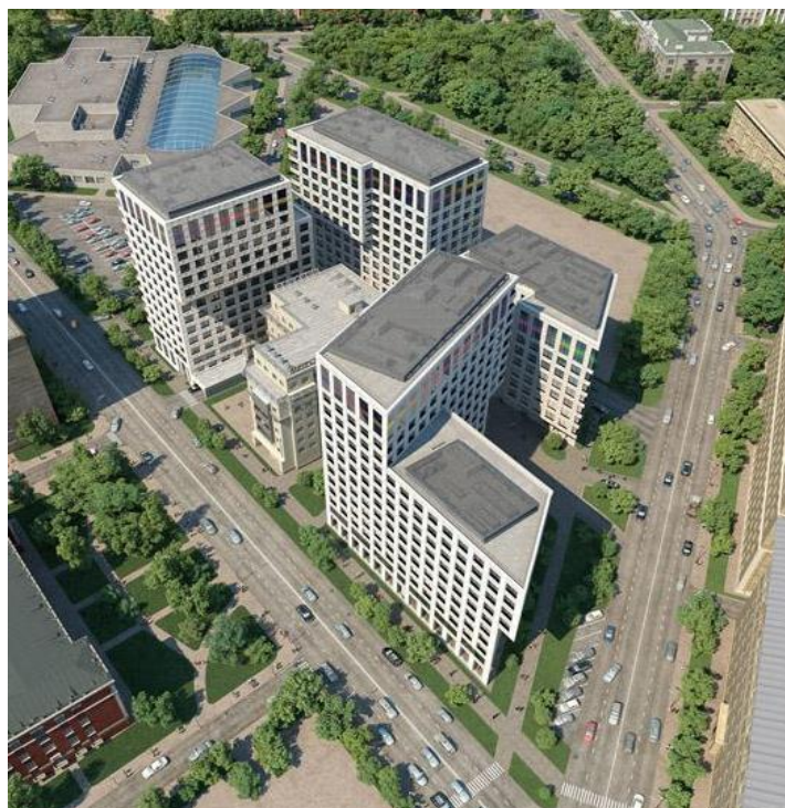
Рис. 1.10 – Общий вид жилого комплекса [68]
