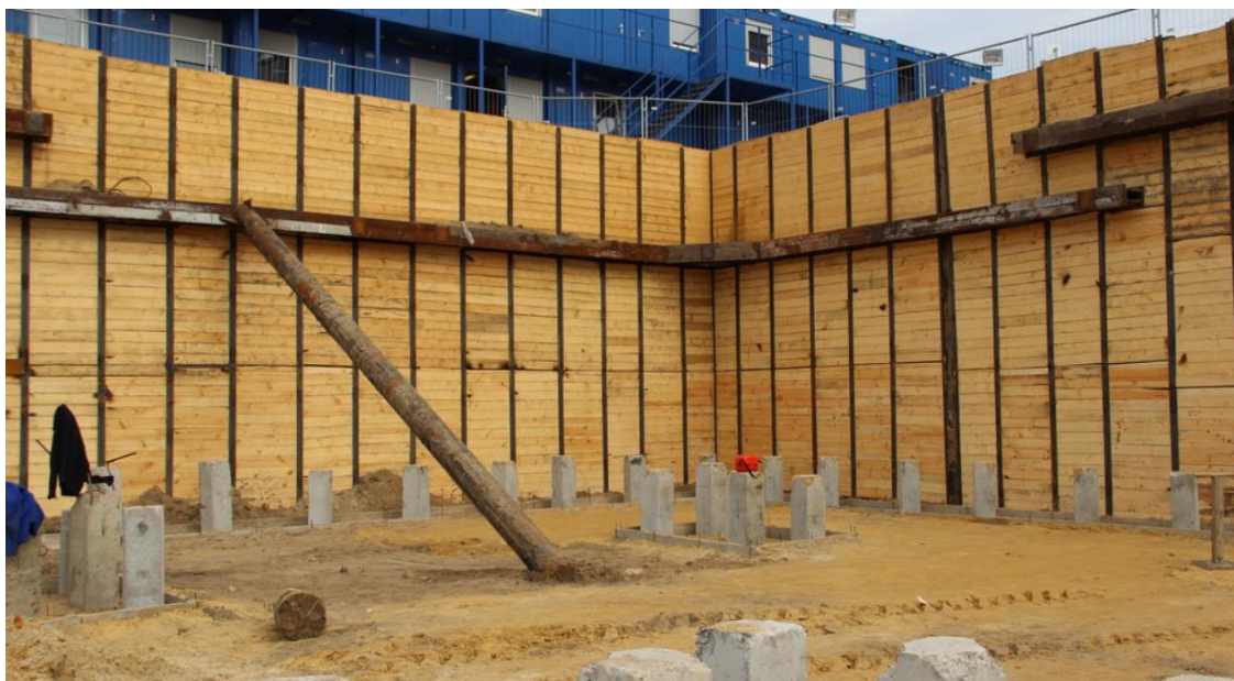
Рис. 1.3 – Ограждение котлована из стальных стоек с деревянной доской [43]
