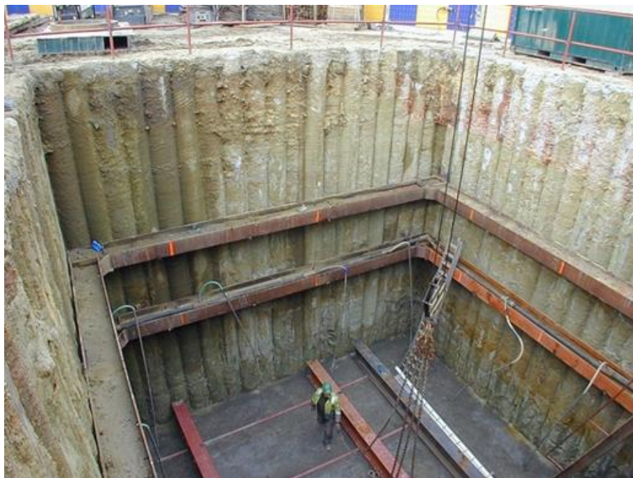
Рис. 1.5 – Ограждение из бурокасательных свай [43]
