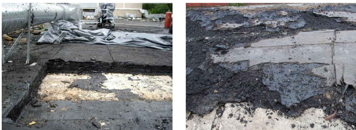
Рисунок 1. Примеры демонтажа многослойного кровельного ковра из рубероида
