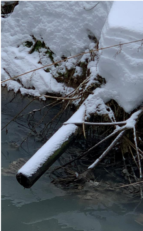
Рисунок 1. Фото трубы для сброса сточных вод
