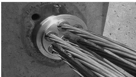
Рис. 3. Анкерное устройство
