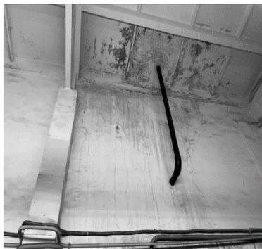
*Рис. 6. Область намокания плиты покрытия и стены общей площадью 3 м<sup>2</sup>, в следствии систематической протечки*
