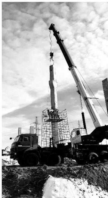
(Рис. 2. Процесс монтажа колонн)
