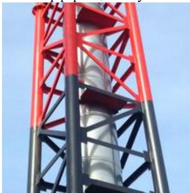
Рис. 1. Пример конструкции газоотводящей трубы с металлическим каркасом
