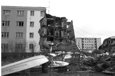
Рис. 3. Обрушение жилого дома в пос.Черский в результате проседания грунтового основания деформации зданий на Крайнем Севере
