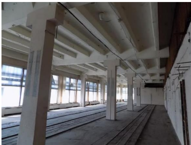
Рис. 3. Общий вид внутренних помещений ликвидируемого здания
