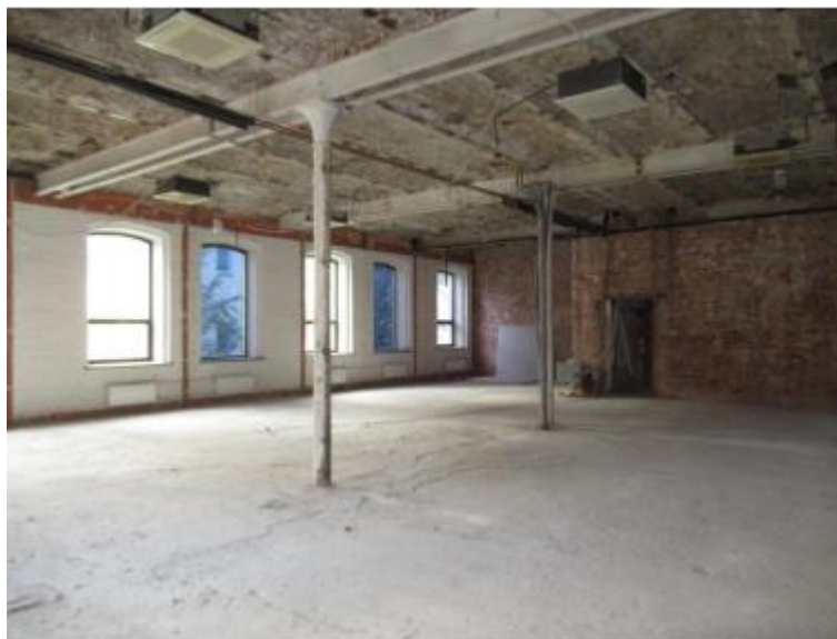
Рис. 3. Общий вид металлических колонн круглого сечения \varnothing 170-190 мм на 2-ом этаже обследуемого здания
