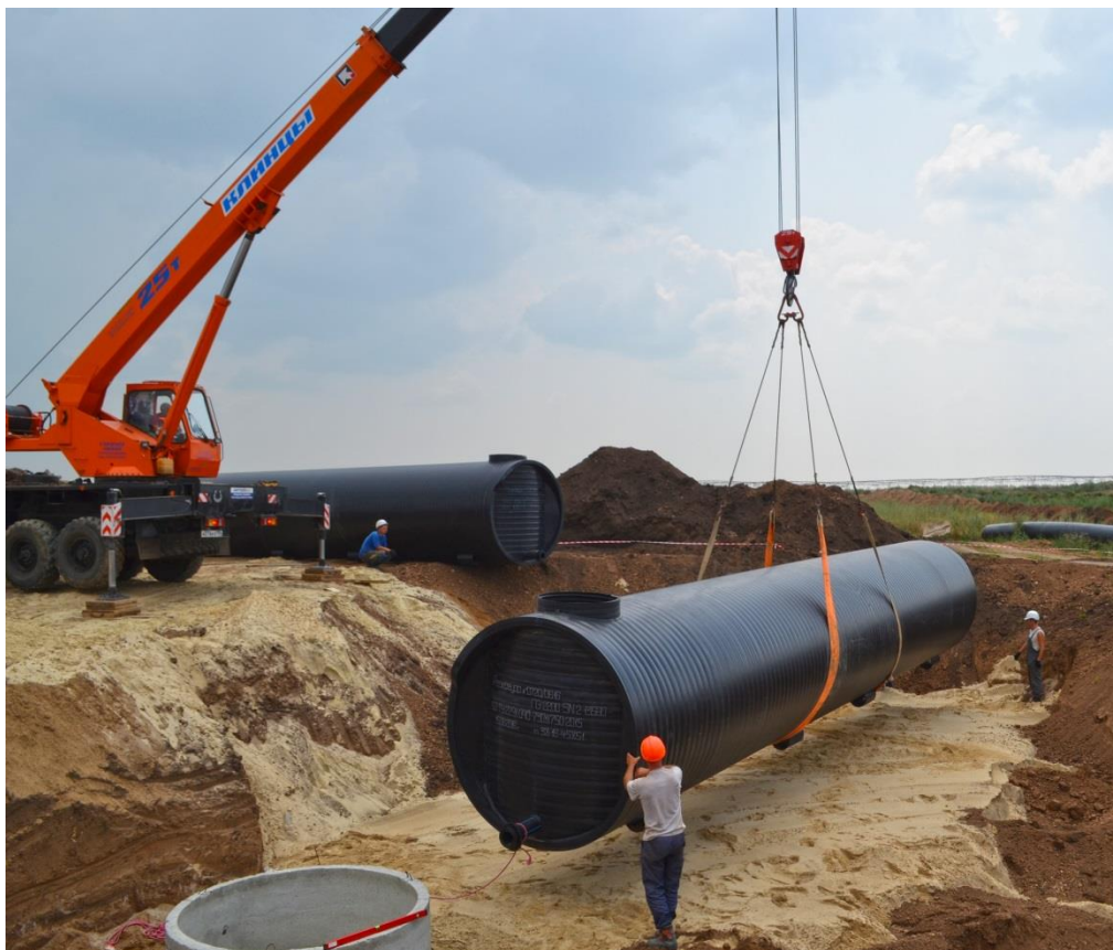
Рис. 1. Монтаж резервуара из полиэтилена.
