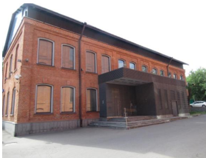
Рис. 1. Фасад обследуемого здания
