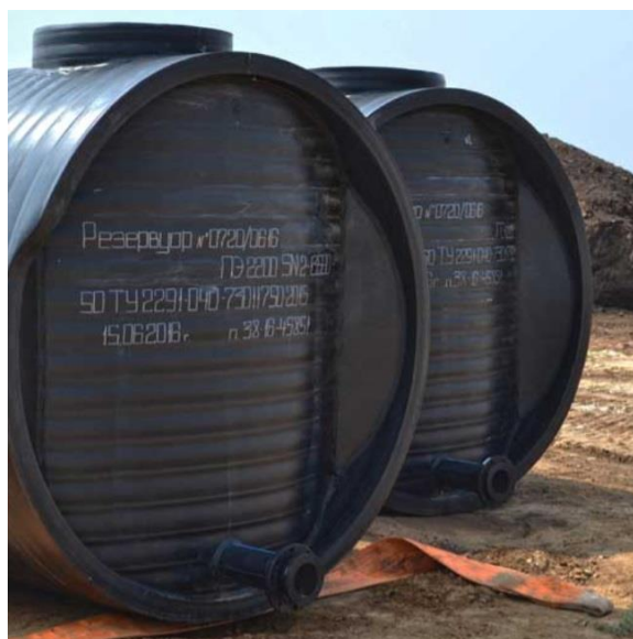
Рис. 3. Патрубки ПЭ резервуара
