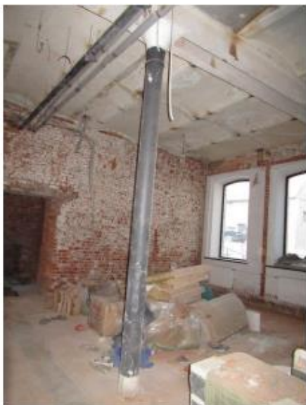
Рис. 2. Общий вид металлической колонны круглого сечения \varnothing 170-190 мм на 1-ом этаже обследуемого здания
