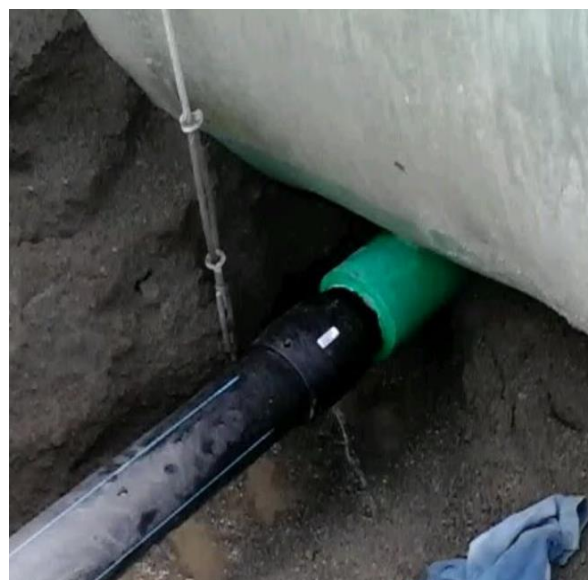
Рис. 4. Патрубок стеклопластикового резервуара
