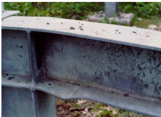
Рис. 1. Местная погибь полки двутавровой балки
