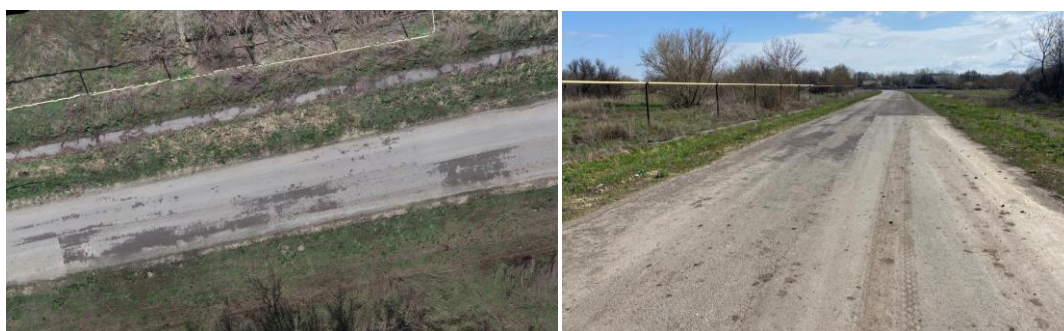
Рис. 3. Влажные участки асфальтобетонного покрытия с высокой пористостью
