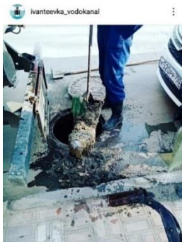
Рисунок 5. Сотрудники Водоканала очищают канализационный колодец от мусора.
