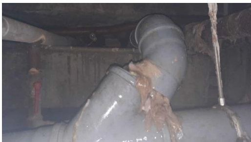
Рисунок 3. Устранение засора в канализационной трубе по адресу г. Ивантеевка, ул. Коминтерна
