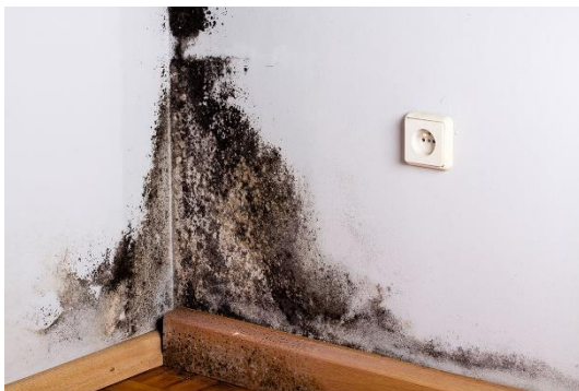
Рисунок 1. Промерзание угла. Черная плесень [11].
