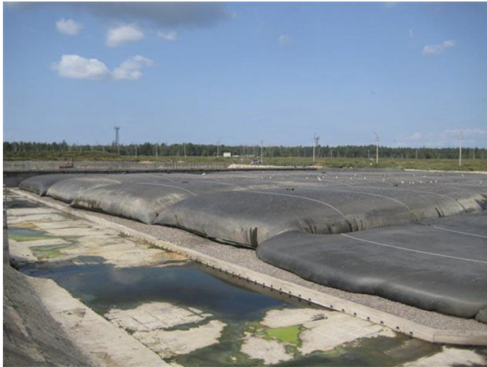
Рисунок 1. Заполненные геотубы на полигоне «Северный»
