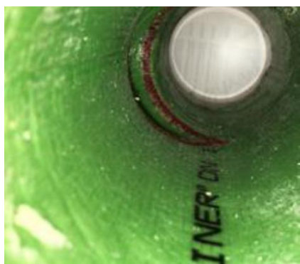
Рисунок 3. Устройство примыканий и отводов с использованием манжет
