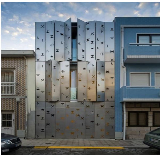
Рисунок 1. Перфорированный фасад на примере жилого дома
