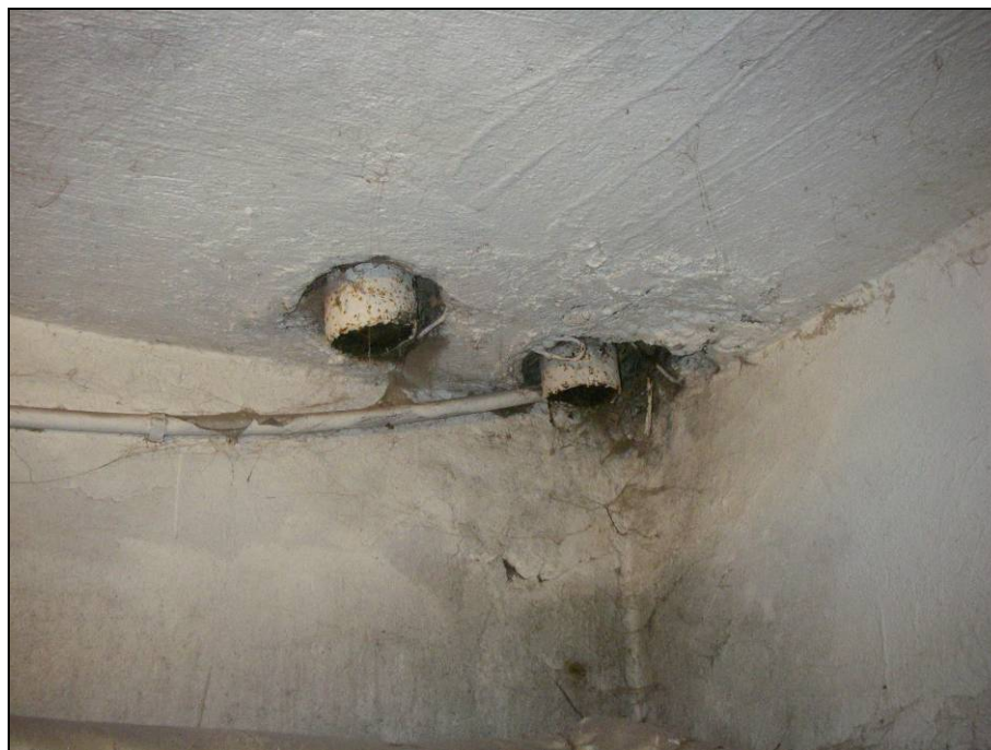
Рисунок 6 - Сколы бетона на участках пропуска труб коммуникаций в плите шириной 0,3 м.
