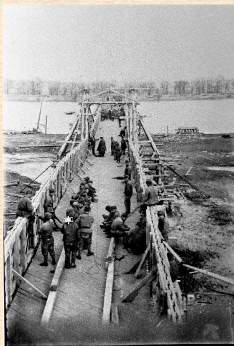
Строительство Висячего Канатного моста через р.Одер в марте 1945г. 9х50 = 450п.м. Кюстринский плацдарм 1 ый Бел. фр. Строили гости 27 го УОС-РГК.
